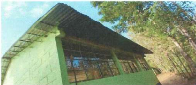
Foto 3: TECHO DEL AULA
