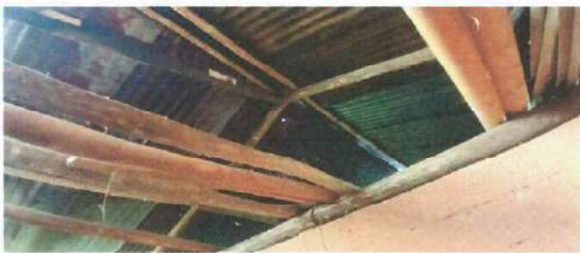
Foto 5: TECHO COCINA DE LA ESCUELA
