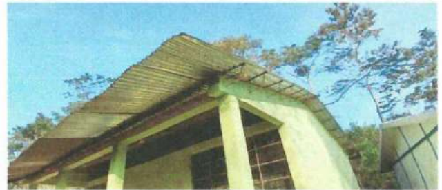
Foto 2: TECHO DEL AULA
