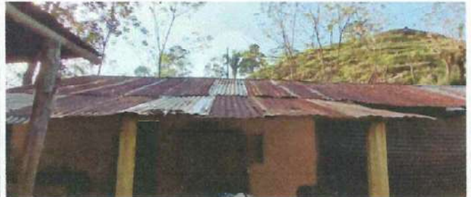
Foto 4: TECHO COCINA DE LA ESCUELA
