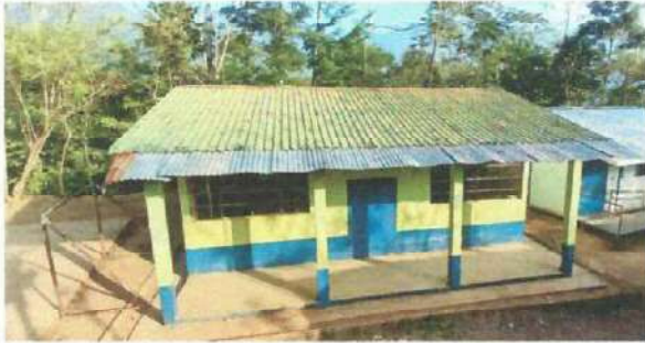
Foto1: TECHO DEL AULA
